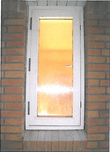
Udv BD30 vindue med råglas Brandtermoglas set inde og udefra
