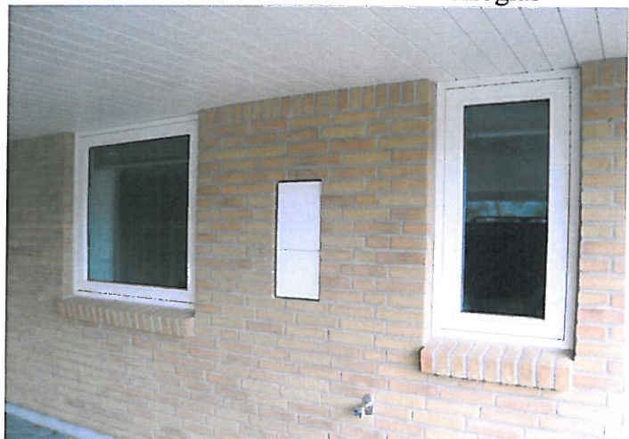
BD30 udv brandvinduer med brandtermoglas
